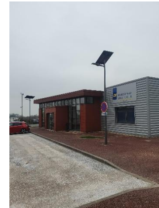
Photo 25 – 26 : Nouveau parking perméable avec de l'enrobé drainant entreprise Garczynski Traploir
