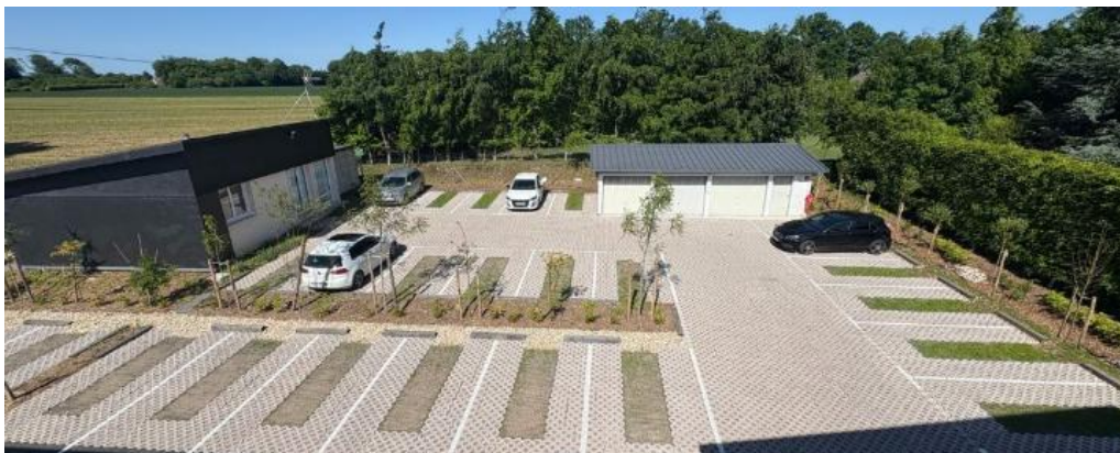
Photo 24 : Nouveau parking perméable entreprise Forchy Pâtisserie qui a permis d'agrandir le parking en baissant le coefficient d'imperméabilisation
