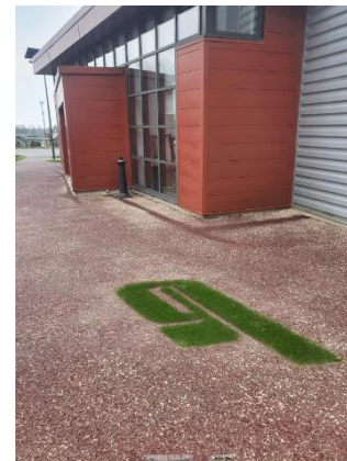
Photo 25 – 26 : Nouveau parking perméable avec de l'enrobé drainant entreprise Garczynski Traploir
