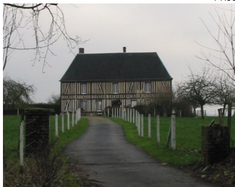
RD 63 : Sortie de bourg vers Limésy (Torchis, Colombage, Ardoise)
