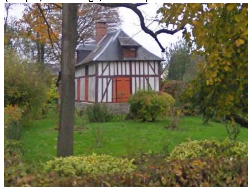
RD 263 : Lieudit Cidetot (Torchis, Colombage, Ardoise)
