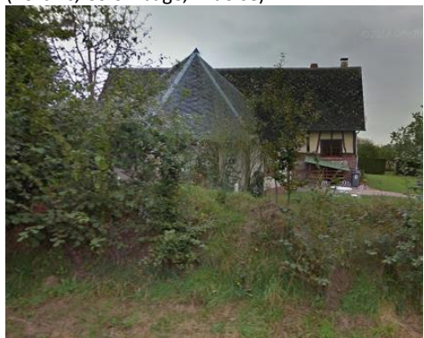
VC 4 : Lieudit Hardouville (Torchis, Colombage, Ardoise)
