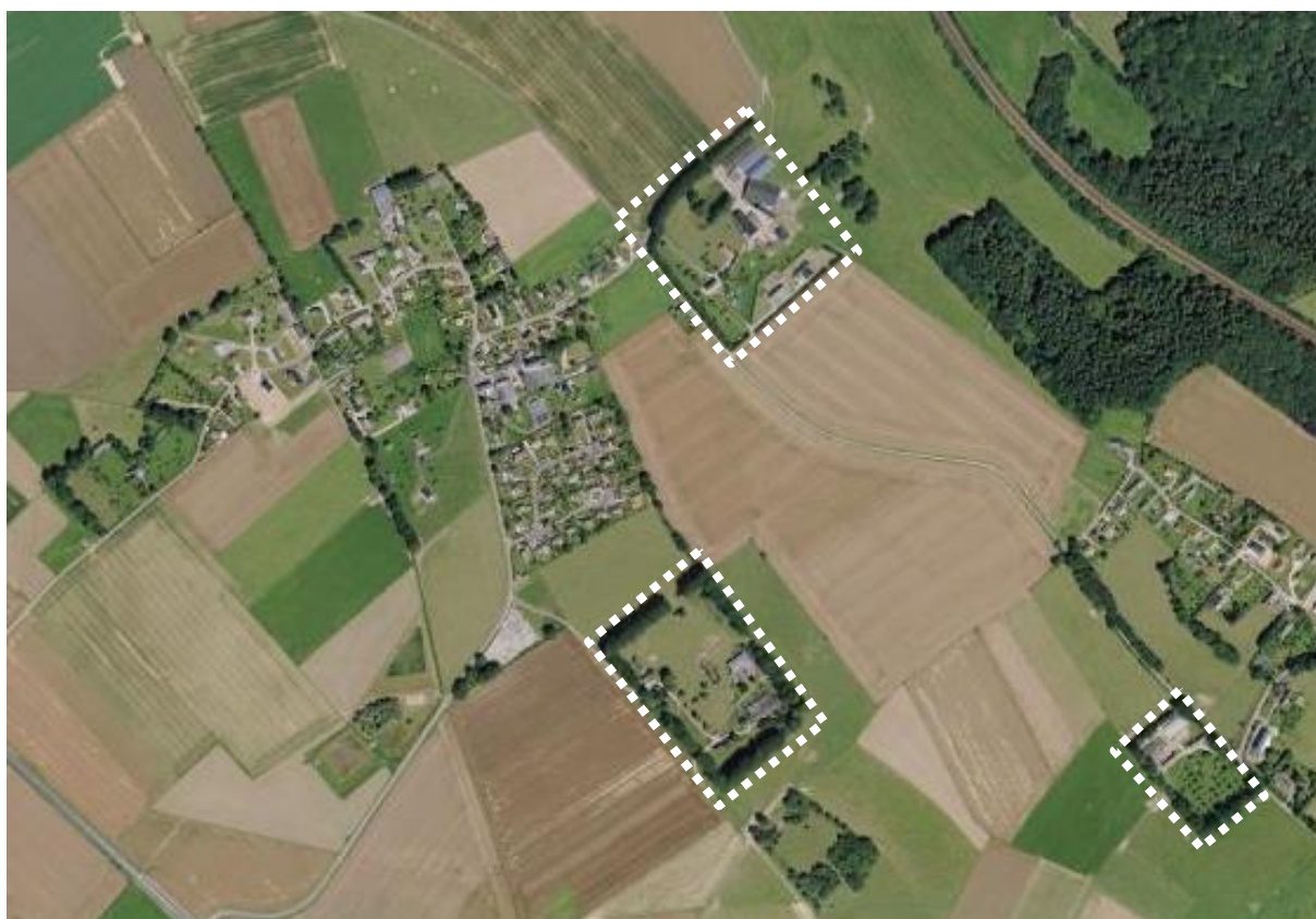
Clos-masure aux abords du Bourg et au lieudit Hardouville Tous ont encore une vocation agricole
