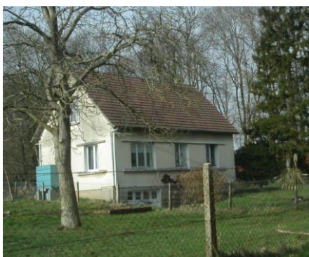
Lieudit Panneville Pavillonnaire des années 60
